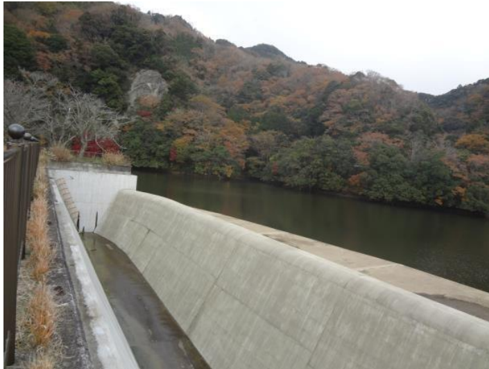
Ilustración 34 Parte del vertedor ya restaurado.
