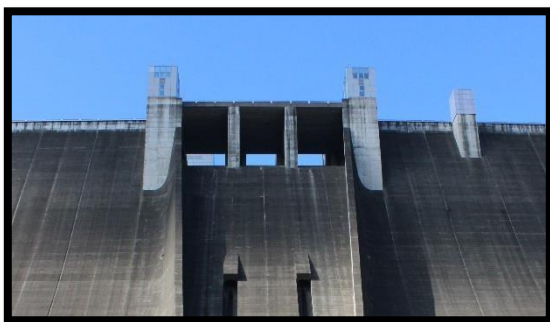
Figura 59. Aliviadero de emergencia.
