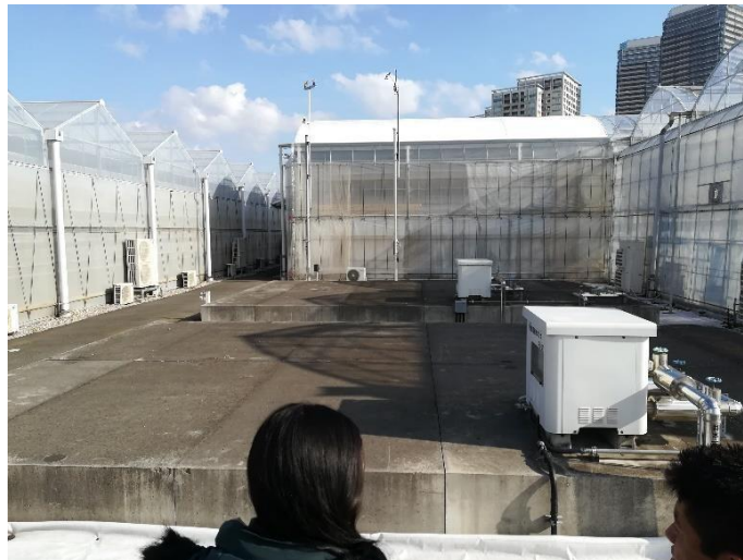
Figura 48 Tanque colector de agua de lluvia.
