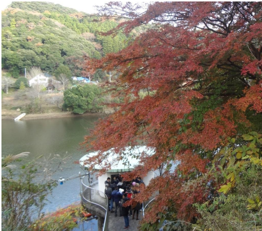
Ilustración 37 Al fondo la obra de toma
