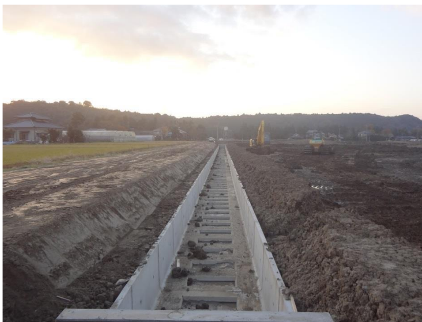
Ilustración 43 Canal de drenaje.
