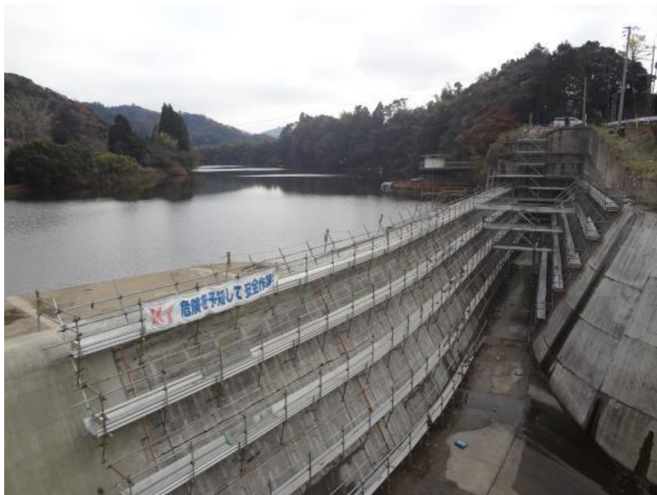
Ilustración 35 Vertedor en mantenimiento recubriendo grietas.
